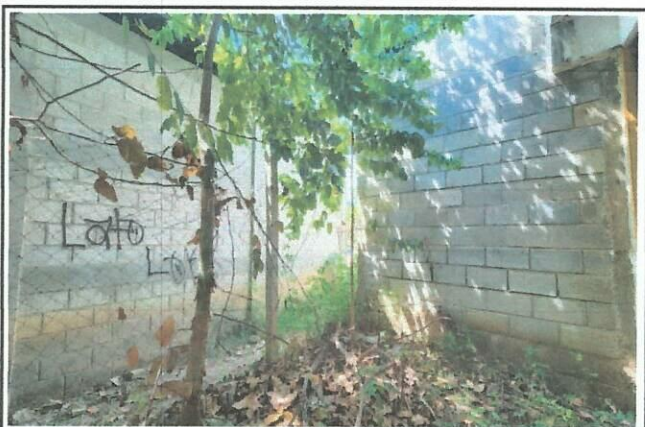
Foto 4: Mantenimiento del área perimetral lado derecho.
