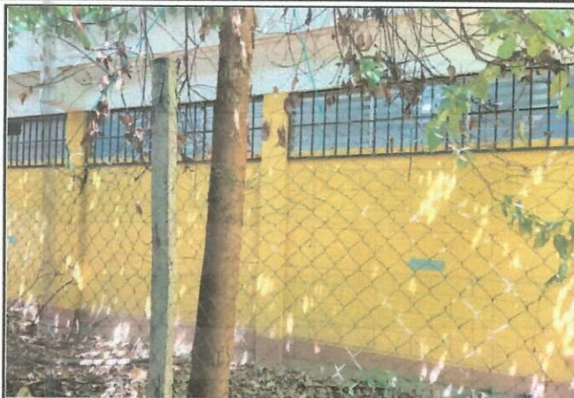
Foto 1: Mantenimiento del área perimetral, lado derecho del establecimiento
