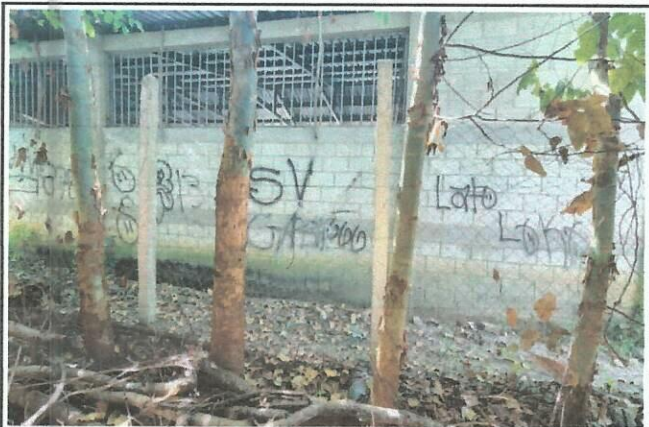
Foto 3: Mantenimiento de área perimetral del lado derecho
